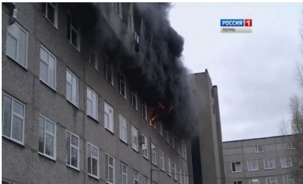
Рис. 1. Пожар в здании больницы (МСЧ 140) г. Пермь
