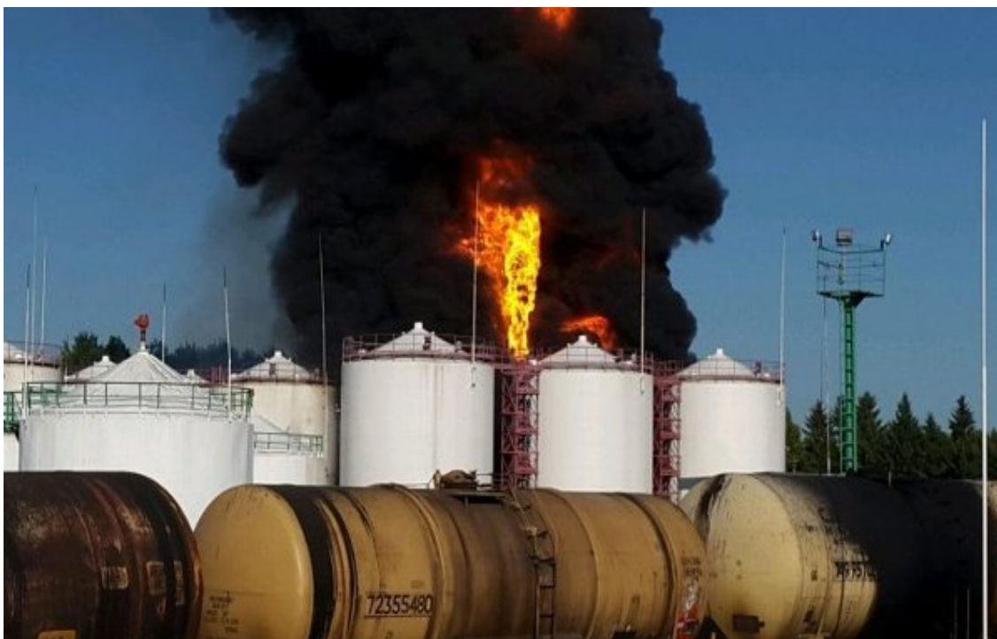
Рис. 2. Горение на дыхательной арматуре резервуара
